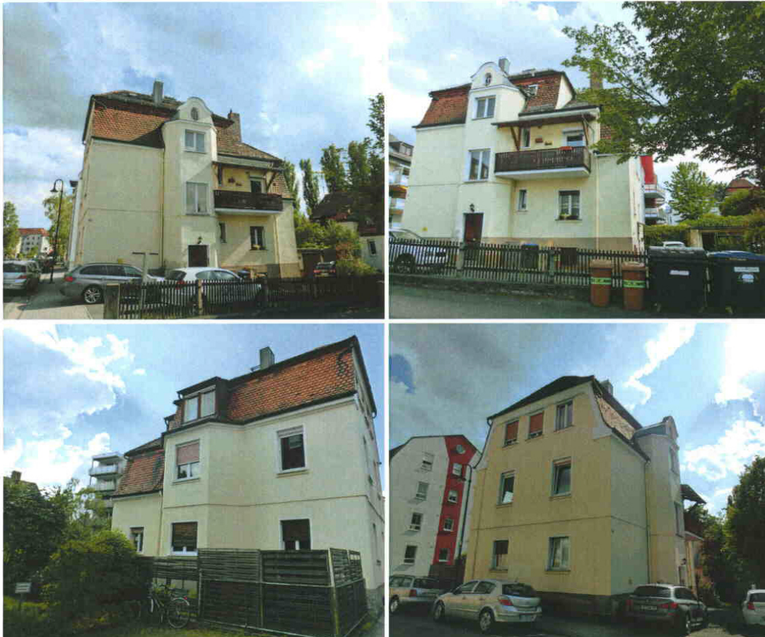
Die Fotos zeigen den Zustand des Gebäudes vor Sanierung
